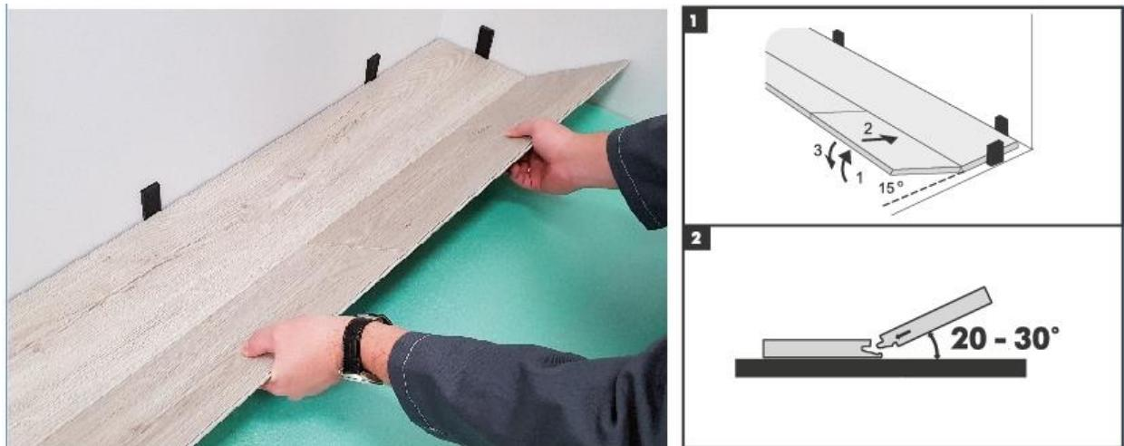
**5. Важно!** В помещениях площадью более 100м<sup>2</sup> необходимо предусмотреть деформационные зазоры не менее 10мм. Длина непрерывного ряда не более 10м в длину и 10м в ширину. **Межкомнатами обязательно нужны пороги! В дверных проемах необходимо оставлять** деформационные зазоры не менее 10мм. После монтажа деформационные зазоры закрываются специальными накладными порогами. (Схема 5).
