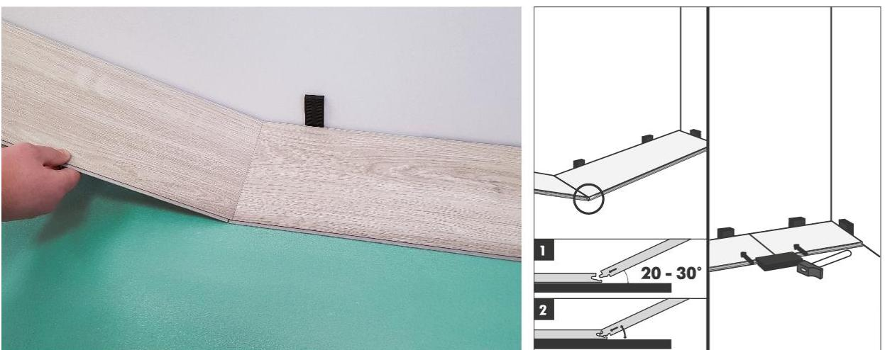
3. Продолжайте соединять первый ряд, пока не дойдете до последней целой панели. Установите последнюю панель, повернув на 180 градусов рисунком вверх. Измеряйте и отмечайте, затем, используя линейку и универсальный нож, прорезайте панель по линии отметки и отламывайте. Прикрепляйте, как описано выше (Схема 3).
